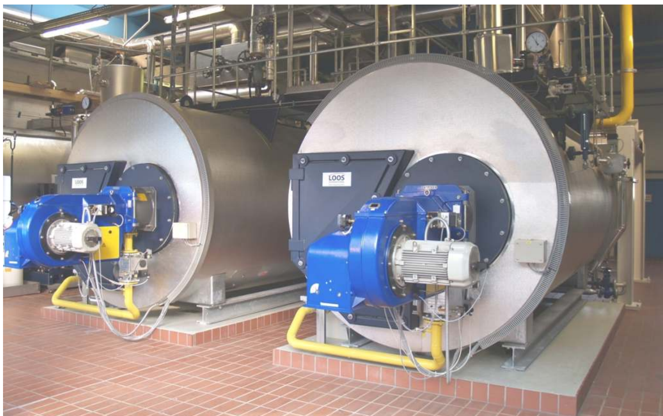
Рисунок 1: Паровой котёл с большим объёмом воды компании ЛООС ИНТЕРНЕШЕНЕЛ в одном из промышленных предприятий
